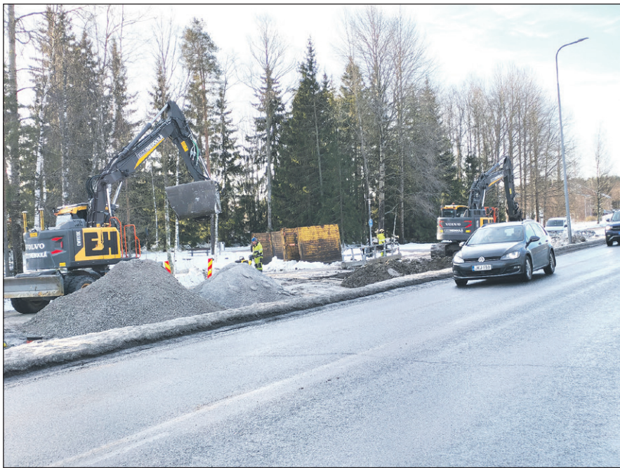
Orimattilan Vesi Oy ja Orimattilan Lämpö Oy ovat käyttäneet rakentamistöissään kiittävästi Orimattilan yrityksiä. Siitä pointsit!
